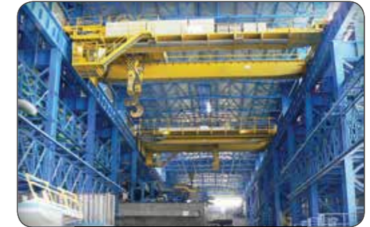
Steel Structures Vian Steel Co.
